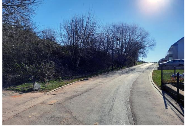
Alpha Topo Luxembourg - Vue sur la zone d'étude et le talus arboré depuis la rue Schabaeschkraiz.
