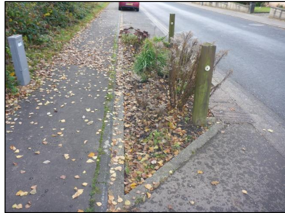
Abb. 2-8: Anpflanzungen von Kräutern und Stauden zwischen den einzelnen Parkflächen entlang der beiden Straßen.
